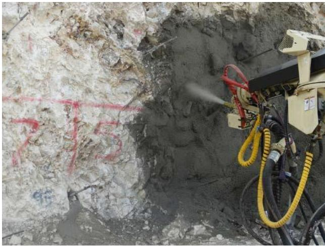
TamCem 60 は最先端のポリカルボン酸エーテルポリマーを使用した新世代のコンクリート用高性能減水剤です。当製品は高い減水性能及び優れたスランプ保持性能を有し、コンクリートの施工性向上に有効な混和剤です。当製品は非塩化物系の液体混和剤で、ヨーロッパ規格 EN 934-2 (Table 3.1 / 3.2) 及び ASTM 規格 C 494 ( タイプ F, 広域減水剤/流動化剤 ) に適合しています。また TamCem 60 は国際標準に沿ったあらゆるセメントに対応しています。
