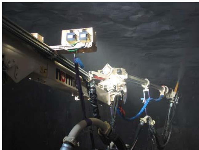
TamShot 110AF は吹付けコンクリート用途を目的とした高性能液体急結剤です。TamShot 110AF は鉱山やトンネル現場における湿式吹付けコンクリート施工において使用されます。この製品は地盤の初期補強が必要な現場や、シンクルシェル構造トンネルの様な耐久性が求められる吹付け用途に対して適用されます。
